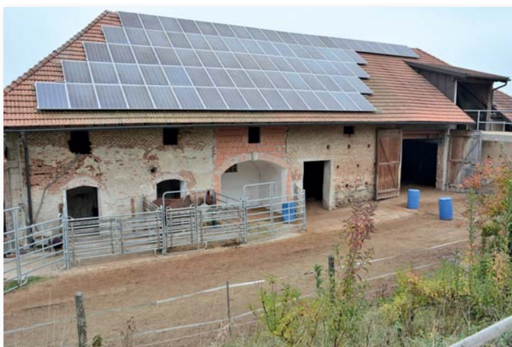
► V pravé části fotografie jsou vidět dva vstupy do odpočívárny a v levé části tři integrační boxy
